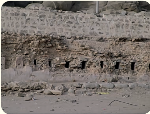
Rahmet dağının eteğinde atalarımızın hacılara su sağlamak üzere yaptıkları çeşmelerin kalıntıları.
